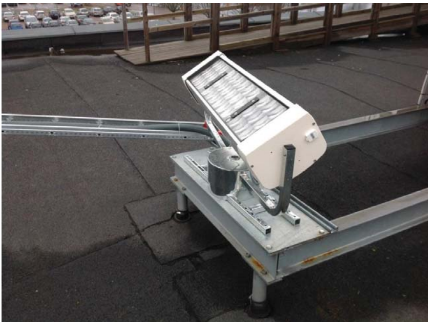
Bild 1. Solfångarmottagare, som anpassar sig efter solens rörelse
