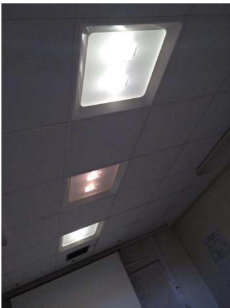
Bild 7. Solljusbelysning med både glasfiber- och plastfibrer i konferensrum. Den mittersta armaturen är kopplad till glasfibrerna.
